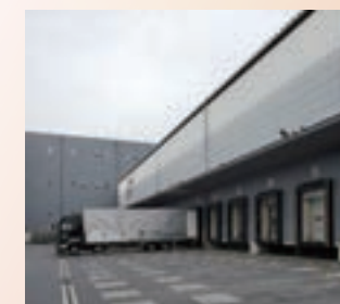
ロジスティクスセンター
